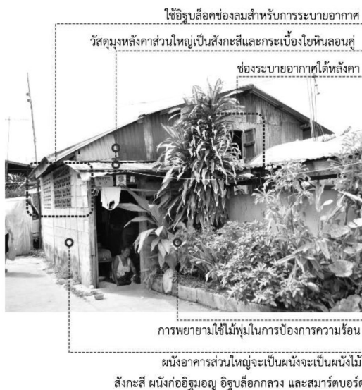
ภาพที่ 18 แสดงการใช้วัสดุอาคาร ช่องเปิดและการระบายอากาศ การใช้วัสดุเหลือใช้มาเป็นอุปกรณ์ป้องกันความร้อน
