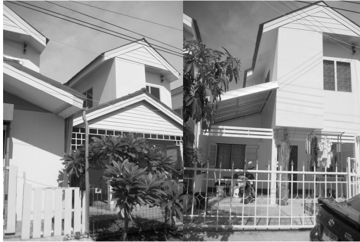
ภาพที่ 2 (ก) การต่อเติมโครงสร้างหลังคา และ (ข) การต่อเติมโครงสร้างหลังคาประกอบพื้นที่ใช้สอย
